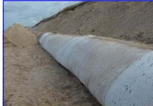
Kerlouan: vista de la estructura STABIPLAGE® implantada en pie de duna - antes de la fase de reperfilado de esta.
